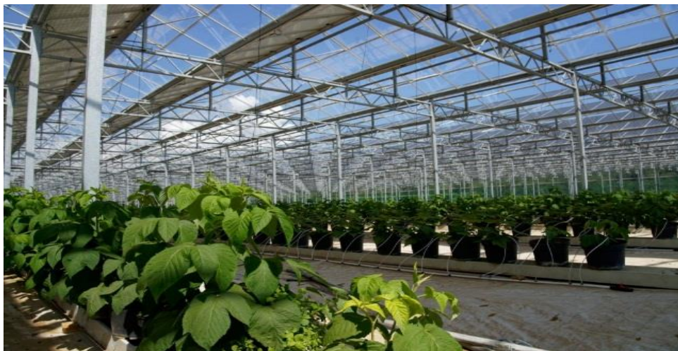
Figure 17. Capteur solaire à air montée en série pour assurer le chauffage d'une serre horticole en verre.
