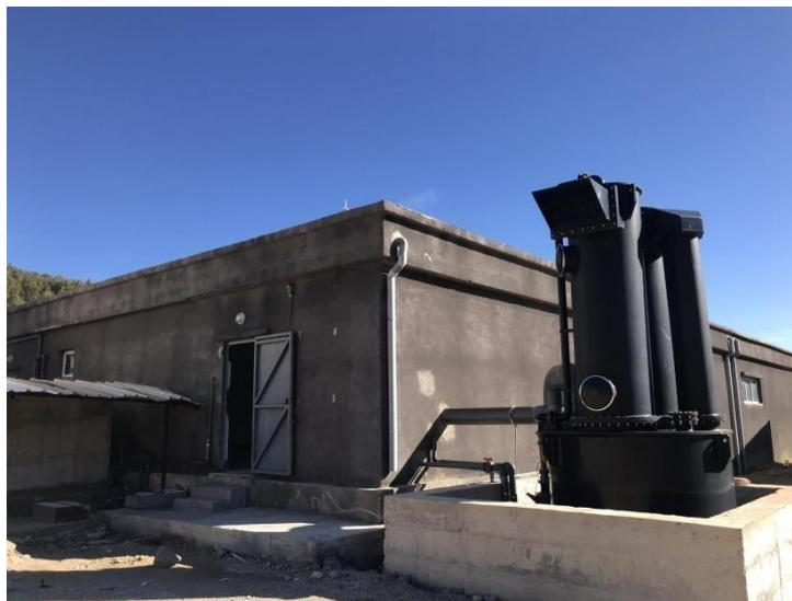
**Figure II.13. Pompe d'injection Du  $Cl_2$**
