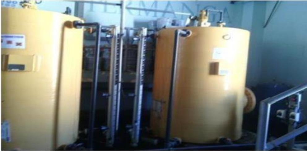
**Figure II.8. Système de préparation du permanganate de potassium dans la Station d'Aïn Tinn**
