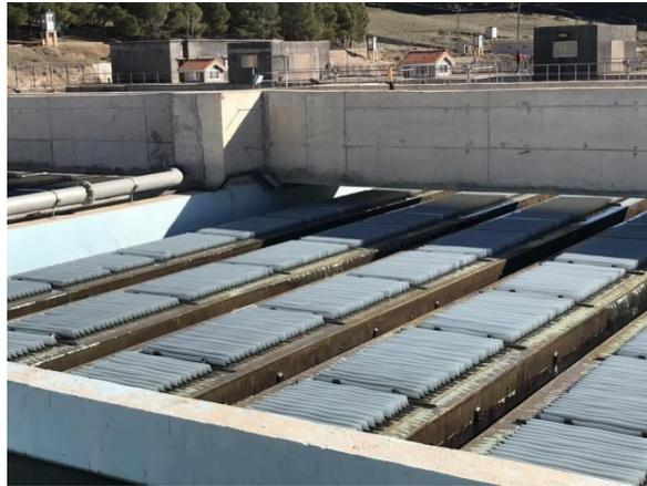
**Figure II.14. Décanteur lamellaire de la station de Mahouane.**
