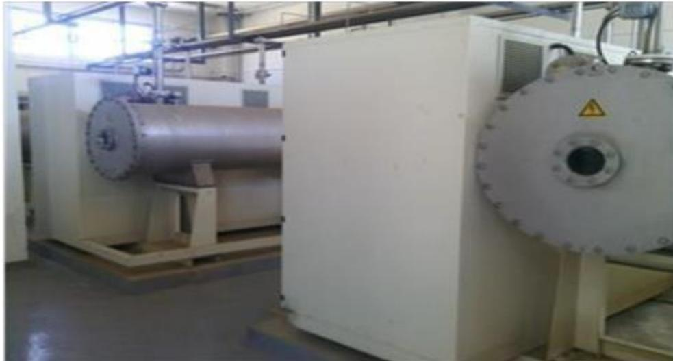
**Figure II.9. Générateur d'ozone utilisé dans la station d'Aïn Tinn**
