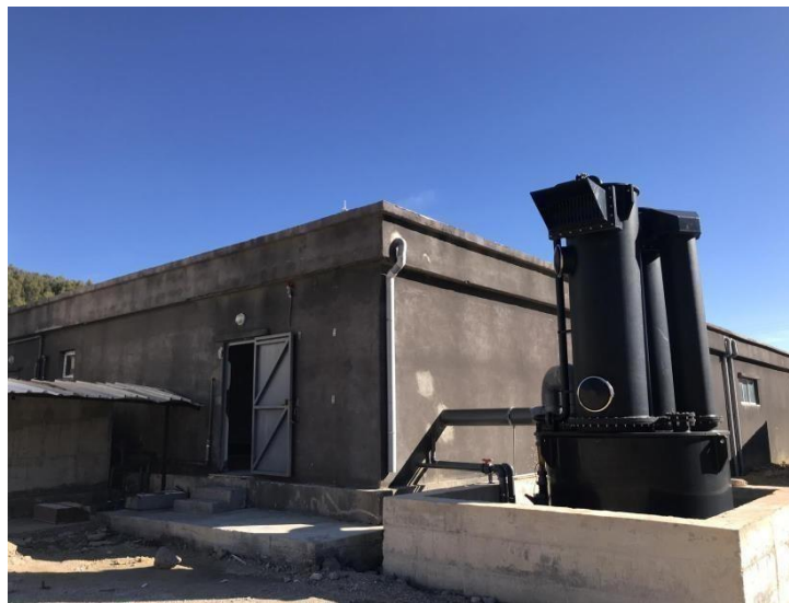
Figure II.13. Pompe d'injection Du Cl_2
