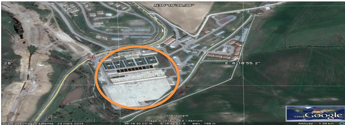
Figure II.2. Vue générale sur la station d'Oued Athmania
